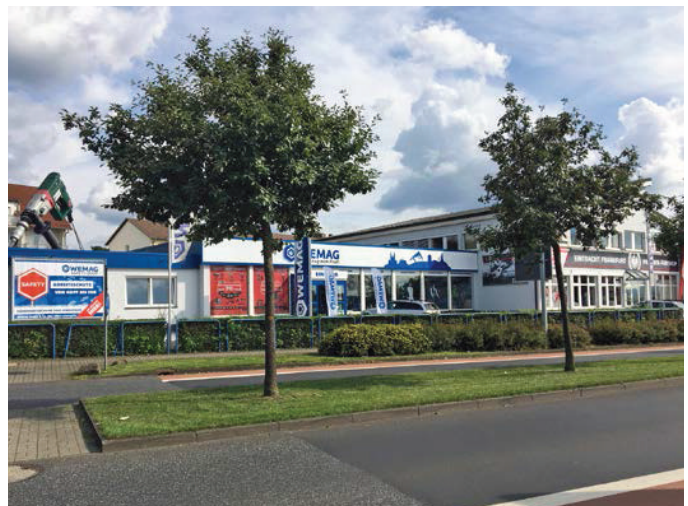
Bei WEMAG in Fulda ist jetzt alles unter einem Dach. (Fotos: WEMAG)
